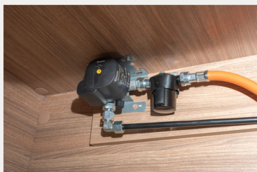
TRUMA MonoControl CS (inkl. Gasfilter)
