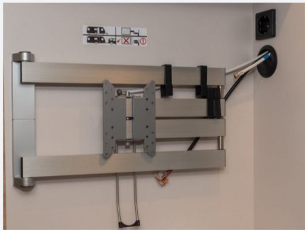
TV-Vorbereitung mit Steckdose und Kabelverlegung/-durchführung
