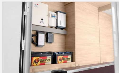
Organisierte Bord-Elektrik & Servicebox
